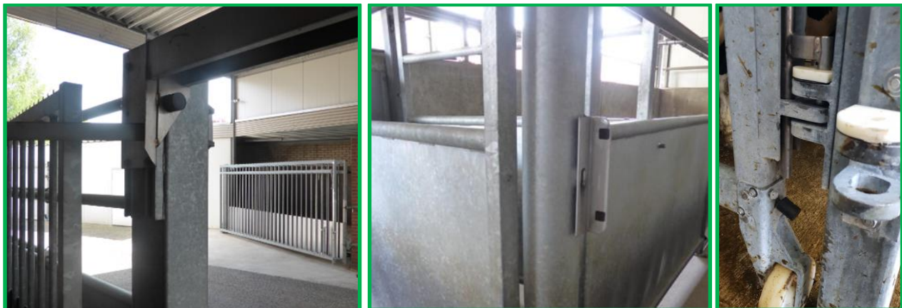
Het plaatsen van rubberen onderdelen, helpt harde geluiden bij het sluiten van hekken verminderen.
