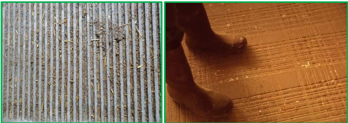
Goede antislip vloer (beton met sleuven eruit gefreesd) bij Feenstra slachterij (links) en bij onbekende slachterij (rechts)
