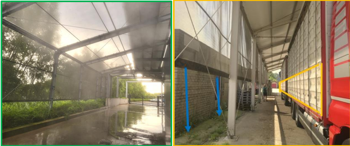
Links: schaduwnet en bomen aan de zijkant van de overkapping bij Westfort. Rechts: schaduwnet dat niet ver genoeg naar beneden kan, waardoor de zon op de onderste kratten schijnt.
