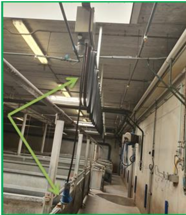
Slinks: snoer en stopcontact aan een rails langs de gehele wachtstal zodat de tang op alle plekken in de wachtstal kan komen. Rechts: karretje om verdoofd en verbloed varken gemakkelijk te kunnen verplaatsen.
